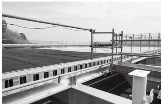
写真5 メッキ処理覆工板と防水シート
