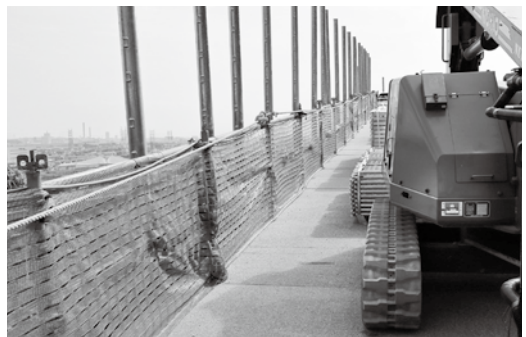
写真6 構台側面の立上げ（施工中）
