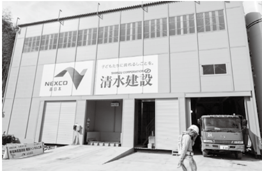
写真14 バッチャープラント
