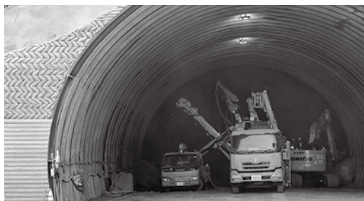
写真9 作業中の吹付機“スコープオン”
