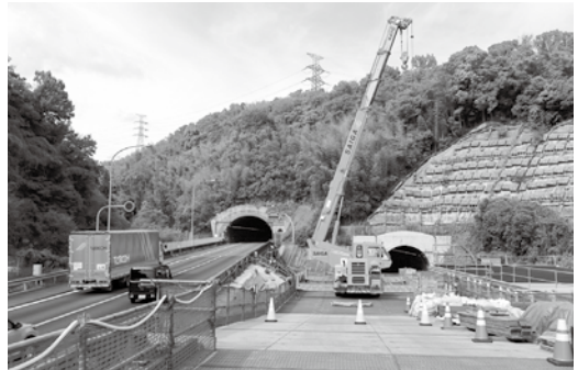
写真4 高槻高架橋下部工 構台全景
