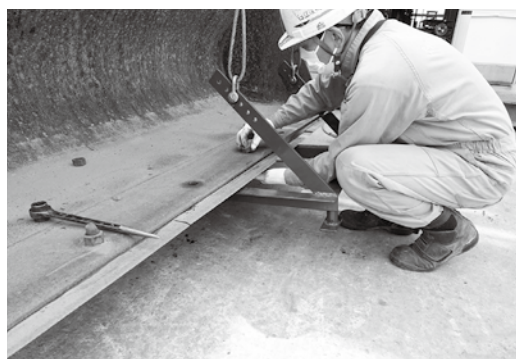
治具を使用しての交換作業
