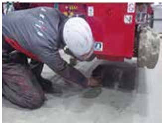
従来は吊った機械の下を覗き込み4カ所木材を合わせていた
