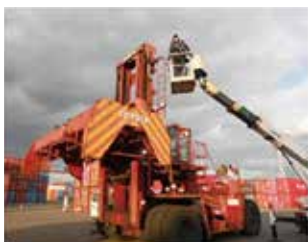
マスト高さ7~10mで 高所作業車を使用しての作業
